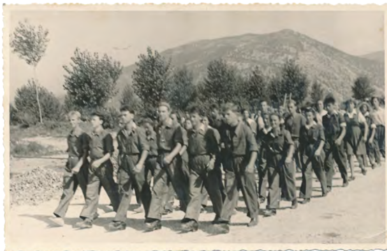
Brigadirji na gradbišču Nove Gorice, 1948. (PANG 583, a. e. 54)
